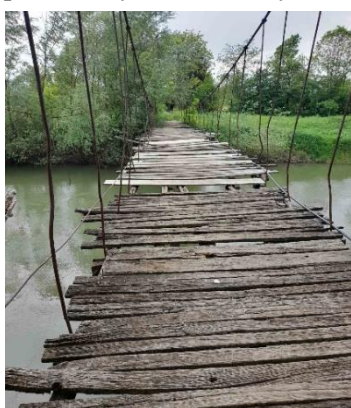
Извор: ДРИ – Viseћи мостови у Краљеву: небезбедан мост за коришћење на Западној Морави (слика лево) и безбедан мост за коришћење на Ибру у Матарушкој Бањи (слика десно)
